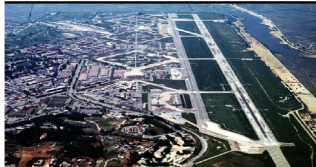
Joint US-ROK Osan air base
