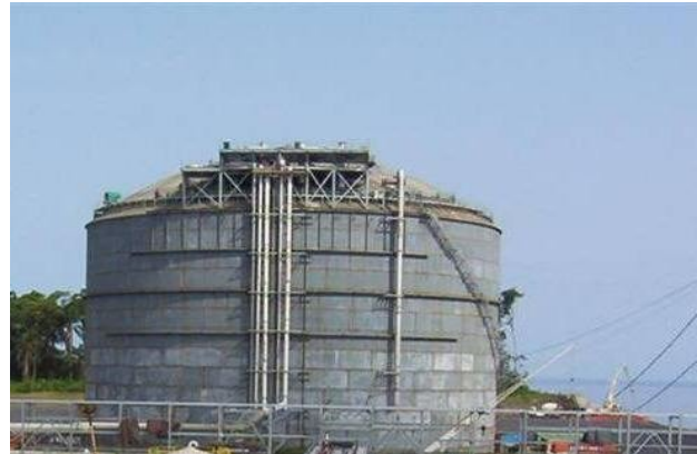
An LNG storage facility
