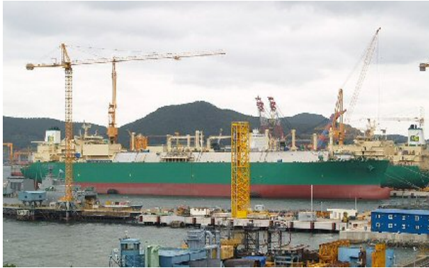
Constructing new LNG cargo ships
