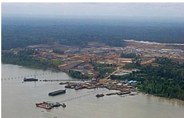
Tangguh LNG facility under construction
