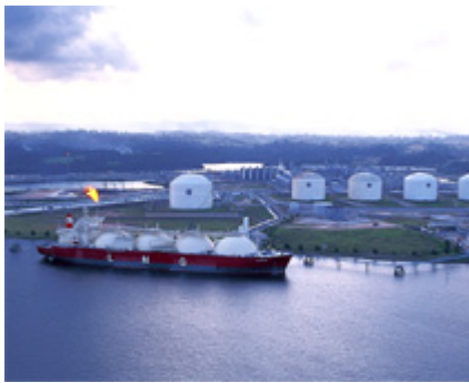
Sumitomo LNG shipment from LNG terminal at Bontang, Indonesia
