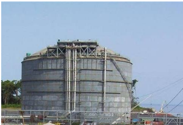
An LNG storage facility
